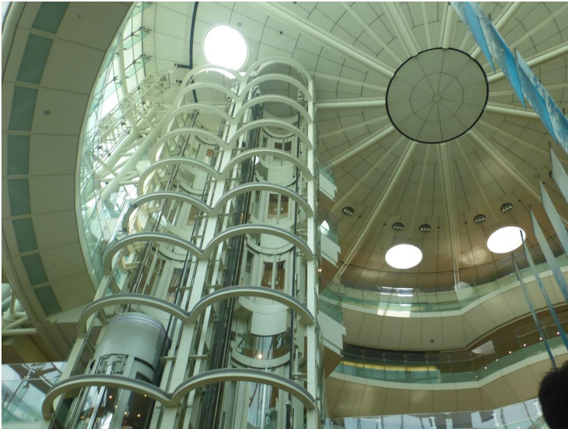
第二ターミナルのエレベーター
